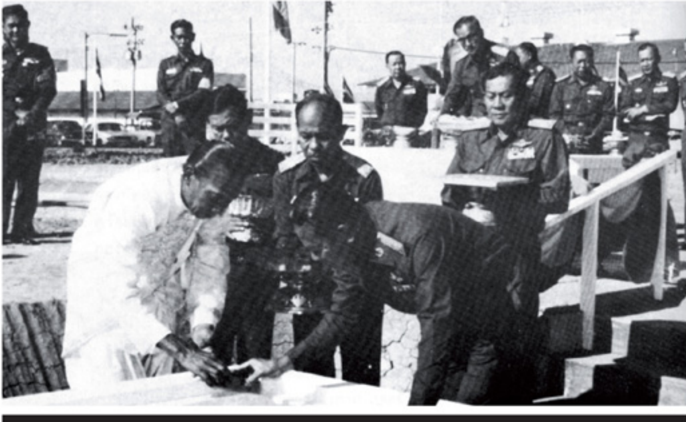
พิธีวางศิลาฤกษ์สถานที่ก่อสร้างอาคารกองบัญชาการกองทัพอากาศ เมื่อวันที่ ๒๑ พฤศจิกายน ๒๕๒๓
